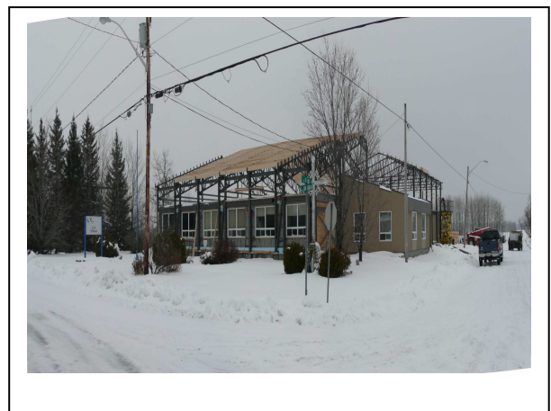
Nouvelle toiture école Tétreault
